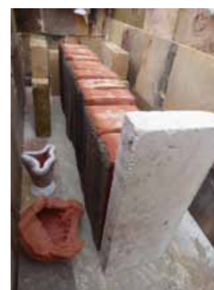
< voor het stoken (vuurhaard kant)(witte steen op de voorgrond is een Itonblok)
